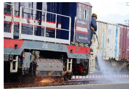
【レール削正車での削正作業】
