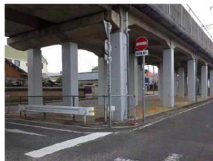
【高架柱の耐震補強】
