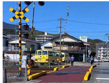
【土讃線 多ノ郷駅構内 水越踏切】
