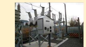
電気設備の更新
