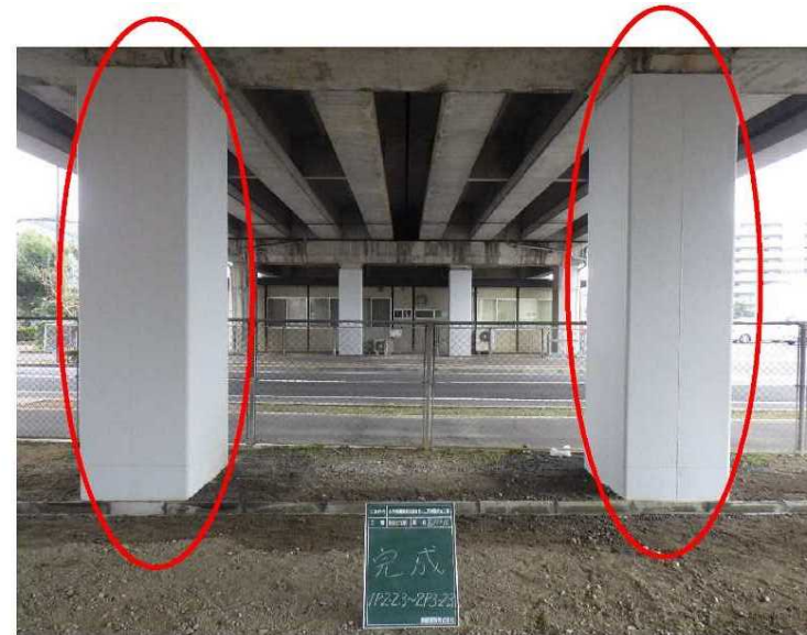
鋼板巻立て補強
