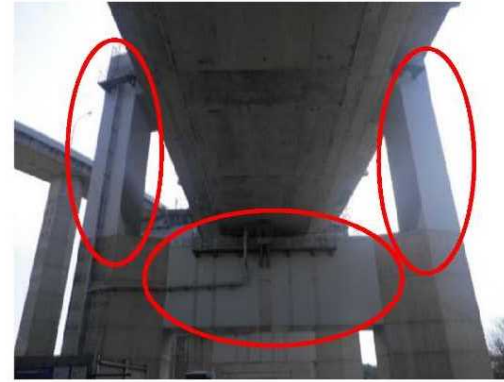
繊維巻立て補強
