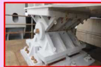
既設トラス桁支承
