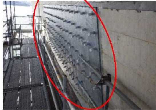
鋼板巻立て補強
