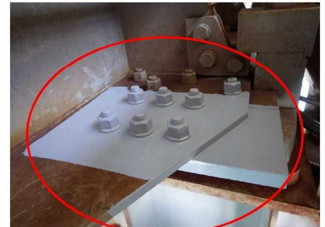
鉄道縦桁補強 (沓補強)
