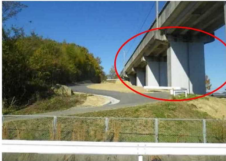
繊維巻立て補強
