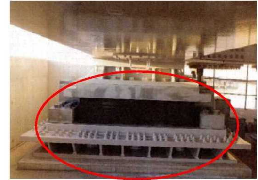
トラス桁支承交換 (免震支承へ取替)
