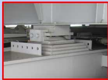
既設道路桁支承
