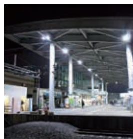
ホーム天井照明のLED化(高松駅)
