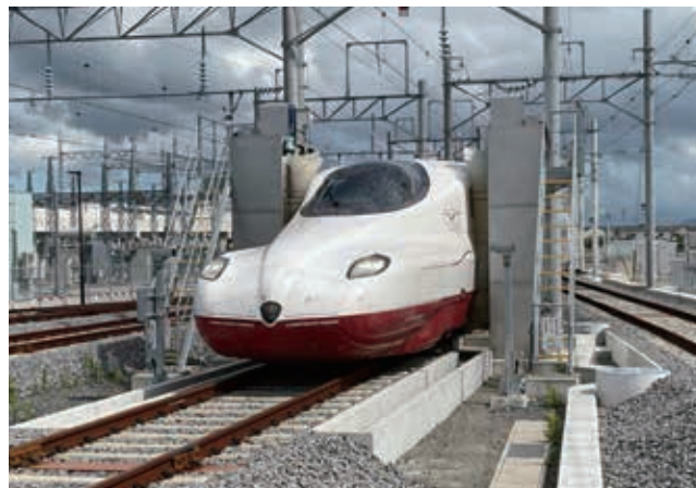
西九州新幹線大村車両基地 車両洗浄装置
