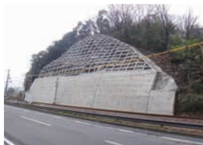
防災対策の一例(のり面防護工)
