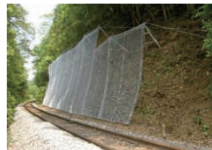
防災対策の一例(落石防止網)
