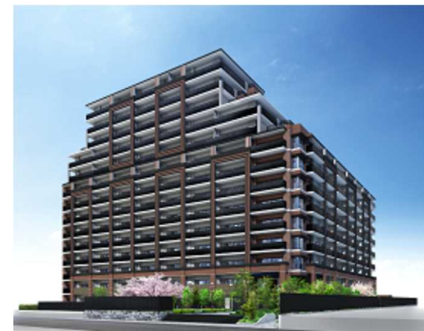
松山市分譲マンション（イメージ） 2022年10月竣工予定
